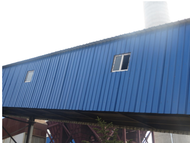
图 3 封闭式输煤栈桥
