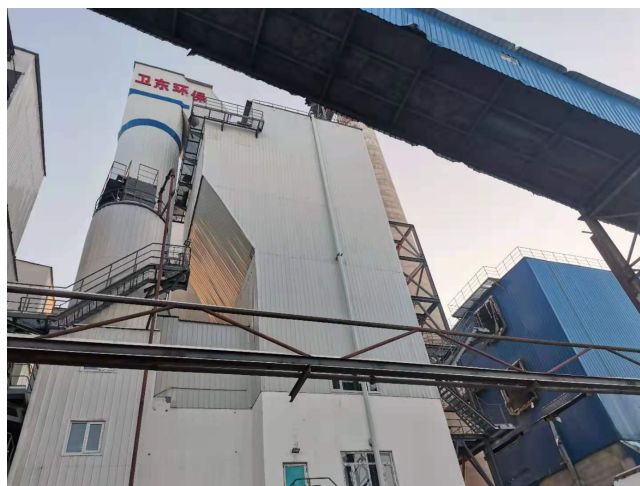
图 2 CFB-FGD 半干法脱硫岛（包括除尘）
