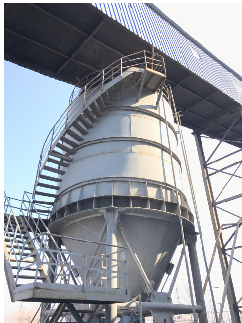
图 2 CFB-FGD 半干法脱硫岛（包括除尘）
